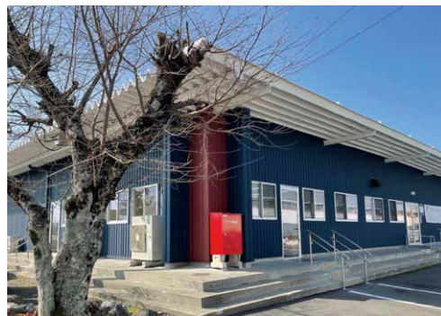
滋賀工場 リノベーション後の厚生棟
