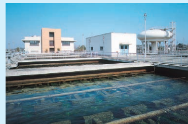
上下水道用電気計装システム
