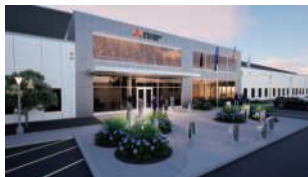
北米向け変電機器新工場棟建設
