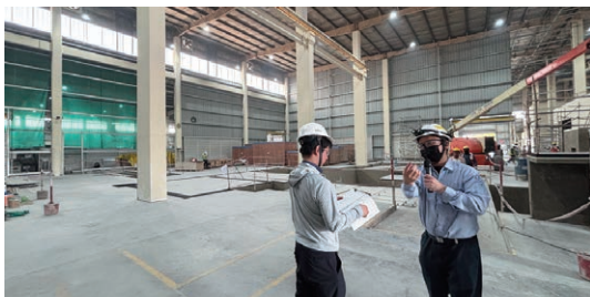
(インド工場 高効率ライン建設中の様子)
