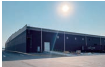
建設中の工場建屋
