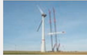
風力発電設備組み立て
