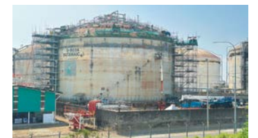
マレーシアでの低温タンク大規模改修工事事例
