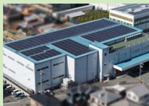
和歌山工場太陽光パネル
