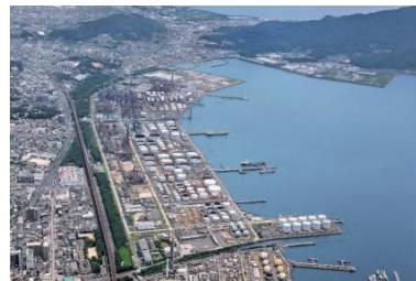
SAF製造装置の建設予定地である 出光興産株式会社 徳山事業所 (写真中央)
