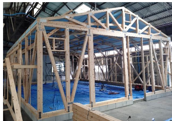
木質材のフレーム構造
