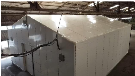
ハウス外観 (完成)
