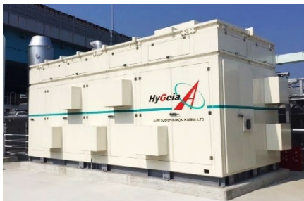
小型オンサイト水素製造装置「HyGeia-A」
