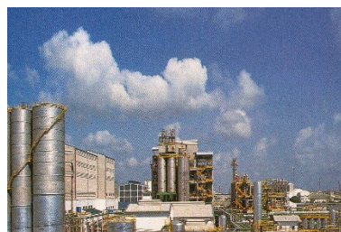
▶ ケミカルプラント建設
