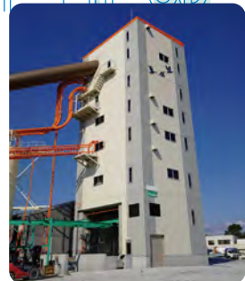
■ コンクリートプラント (BP関連事業)
