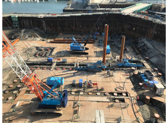
2017 年から 2 工区にわたり行われた水門基礎工事の様子
