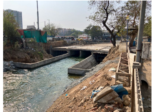
工事区間の現状（一部）
