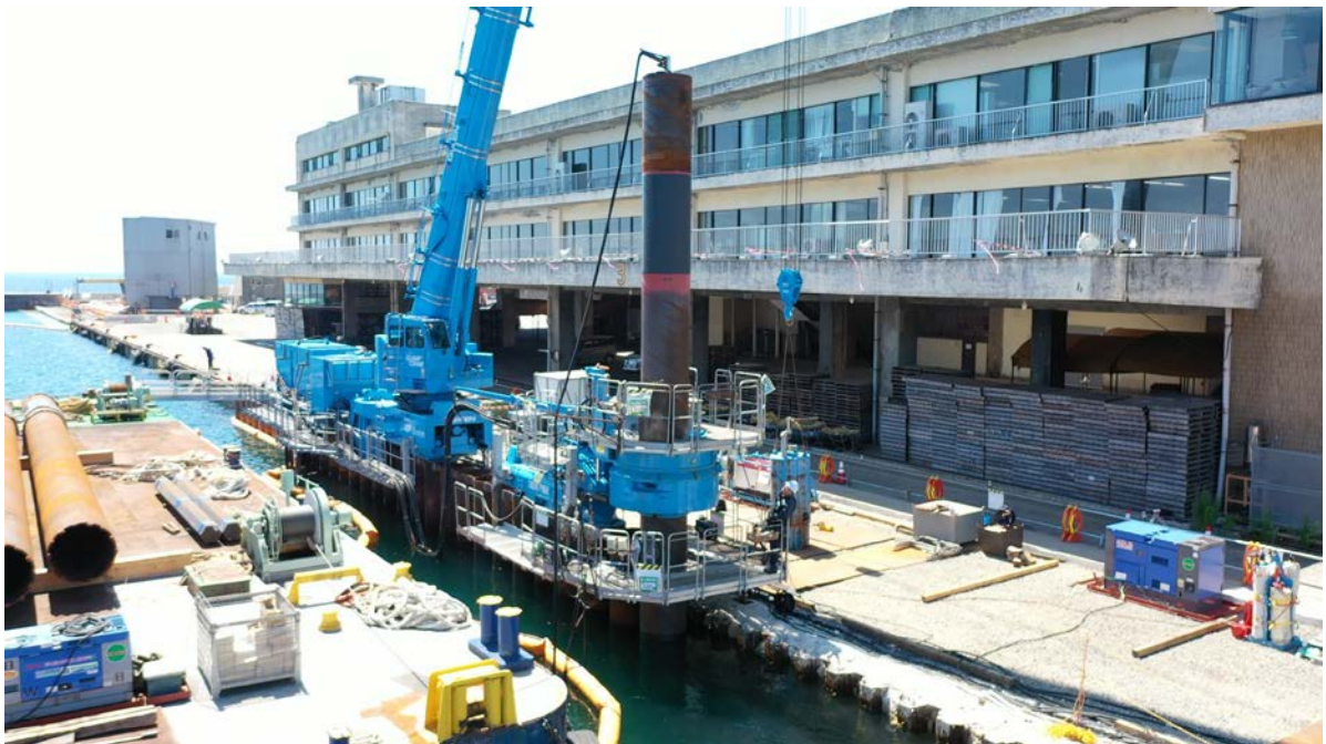
「ジャイロプレス工法™」「GRB システム™」による小木港の岸壁復旧工事
