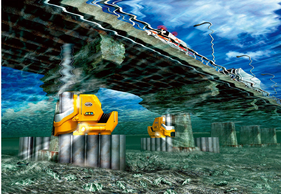
水中パイラーの施工イメージ
