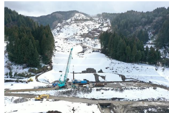
石川県輪島市市ノ瀬町の災害復旧工事
