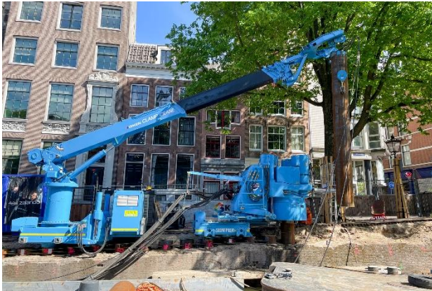
世界遺産運河の護岸改修PJ 商業化フェーズも好調なスタート
