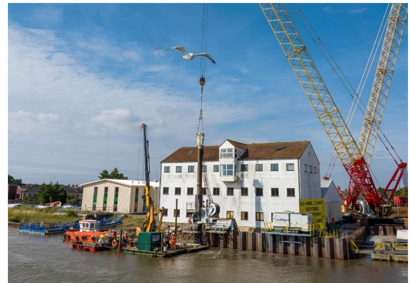
イギリスのGTOSS会員・Ivor King (C.E.C.) Ltd. による圧入施工の様子
