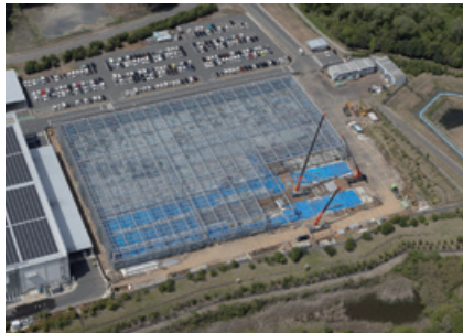
下妻倉庫 (茨城県下妻市)
