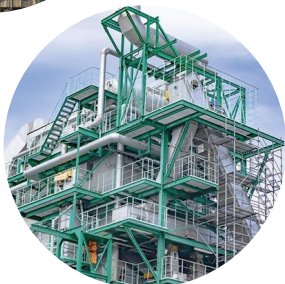
バイオマス発電施設
