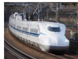
鉄道架線・電線など インフラ設備
