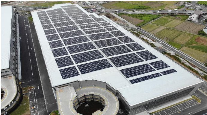
ロジスクエアふじみ野 A 太陽光発電所設備（当社撮影）
