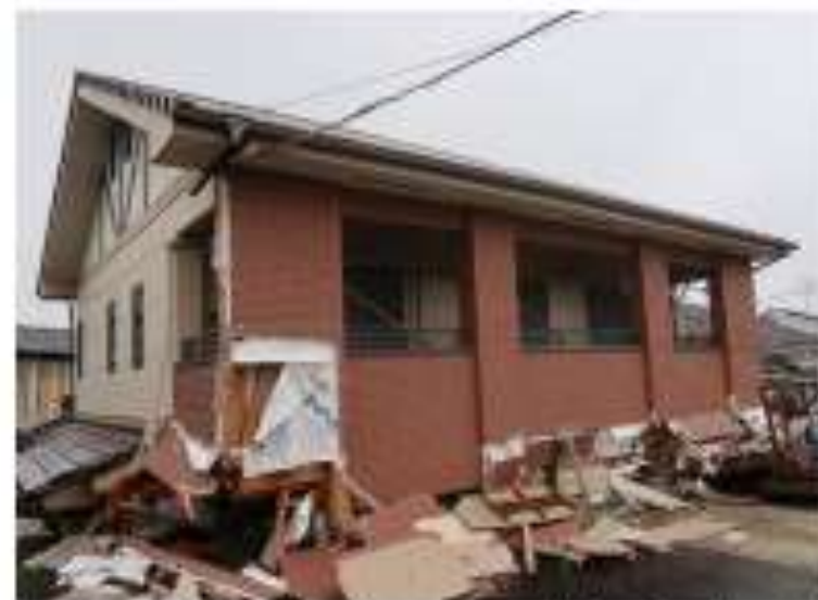
地震後（木造2階建ての1階部分の柱が引き抜けて根元から折れて崩壊）
