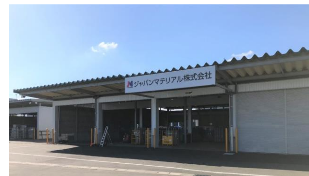
▲四日市外部倉庫（保税蔵置場）
