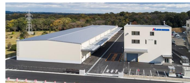
▲テクニカルサポートセンター（左：倉庫棟、右：技術棟）
