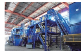
ASRリサイクル施設
