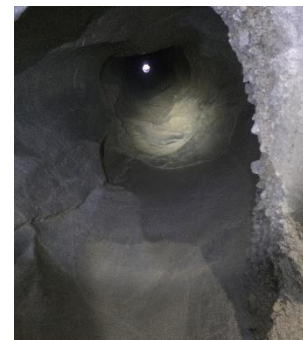
立坑内部の様子 (小割室から上部を目視)
