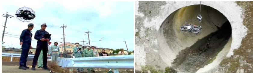
大阪府富田林市での技術検証の様子 (左) と管渠に進入するELIOS 3 (右)
