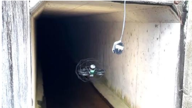
大阪府富田林市にて ELIOS 3 を活用した下水道点検技術 管渠に進入する ELIOS 3 の検証
