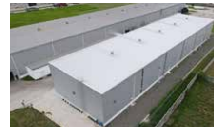
MPST社第2工場
