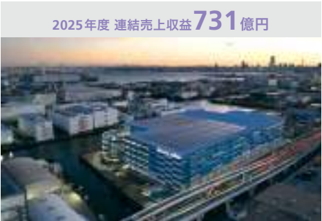
鋼構造技術と環境配慮設計により、「水辺と共存するスマートエネルギー倉庫」の実現に貢献／MFLP横浜新子安
