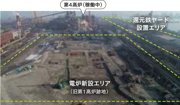
九州製鉄所八幡地区の工事実行状況（2026年4月）
