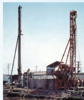
寝屋川護岸工事
