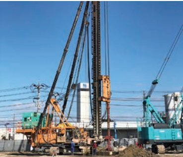
既製コンクリート杭工事
