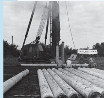
ONAパイルのハンマー打撃試験
