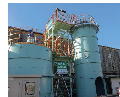
滋賀工場に建設したパイロットプラント
