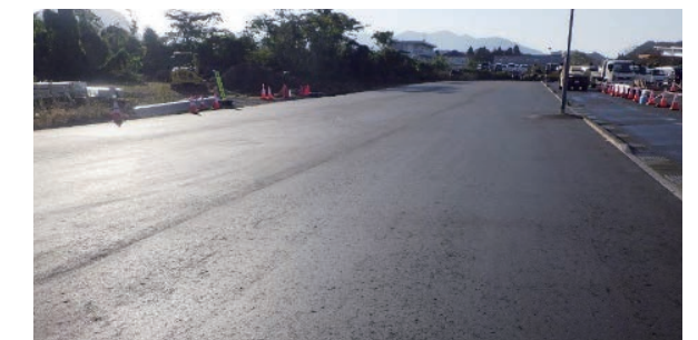
施工完了したアスファルト
