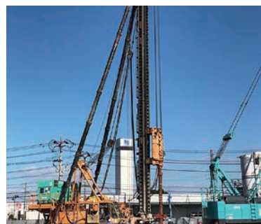
既製コンクリート杭工事
