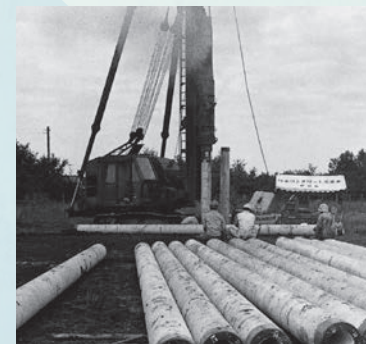
ONAパイプのハンマー打撃試験
