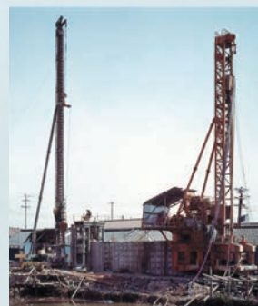
寝屋川護岸工事
