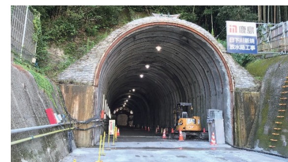
日下川新規放水路トンネル(高知県)
