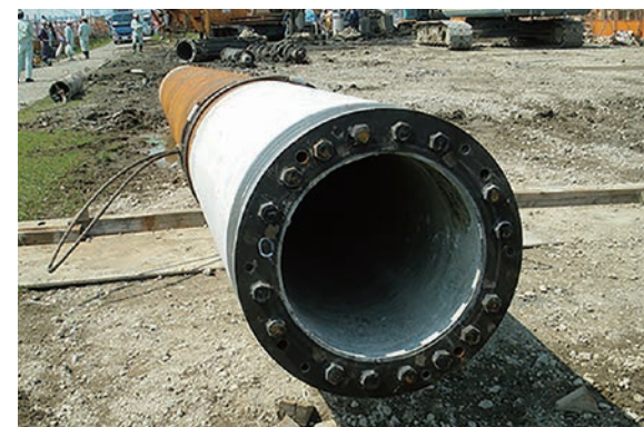
RSCP杭(パイル)
