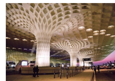
施工例: インド ムンバイの空港
