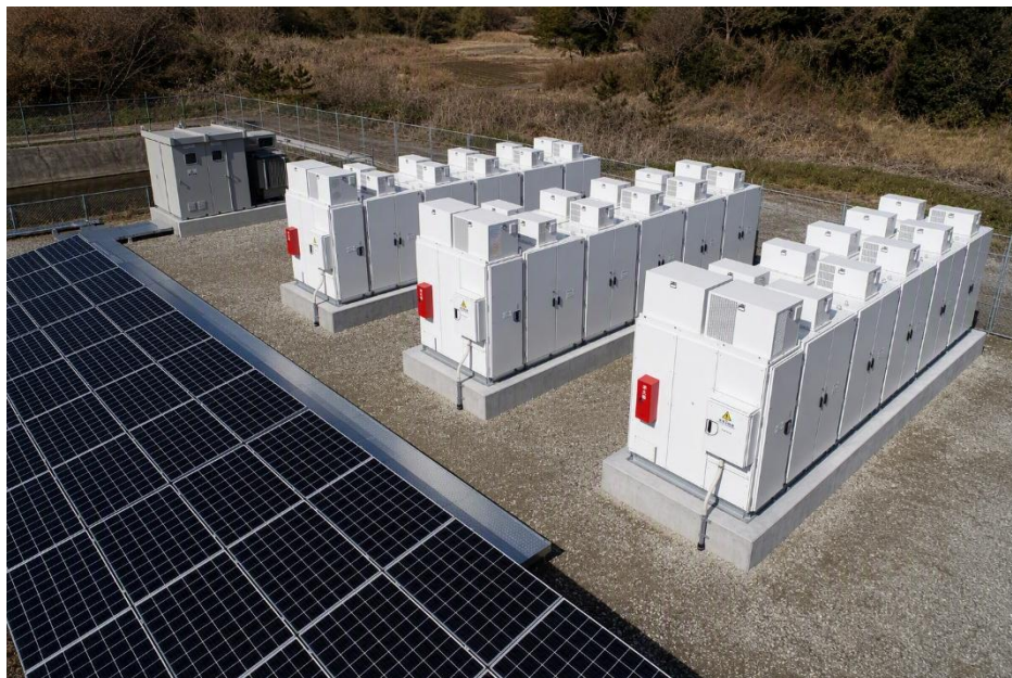
蓄電池を併設した太陽光発電所「福岡・飯塚第一メガソーラー発電所」（所在地：福岡県飯塚市）
