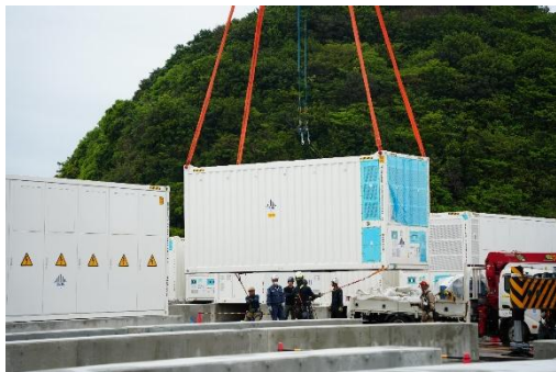
静岡菊川蓄電所での 主要機器の搬入・据付の様子
