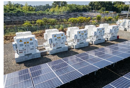
FIP転＋蓄電池併設で運用する 自社太陽光発電所
