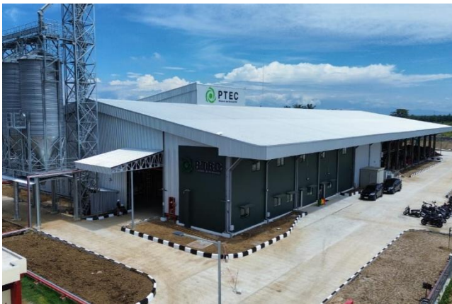
「EFB ペレット」製造の実証を行う工場
