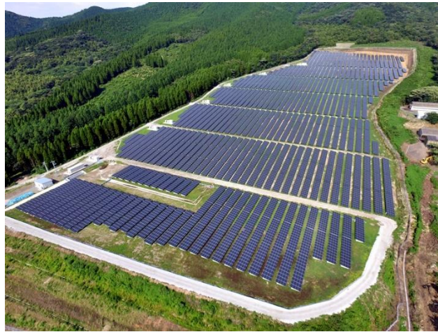
蓄電池を併設する太陽光発電所「くまもとんソーラー発電所」（所在地：熊本県菊池市）
