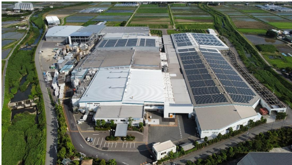
設置場所：九星飲料工業 伊都工場
