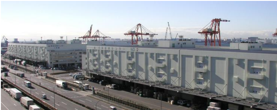
設置場所：青海流通センター
