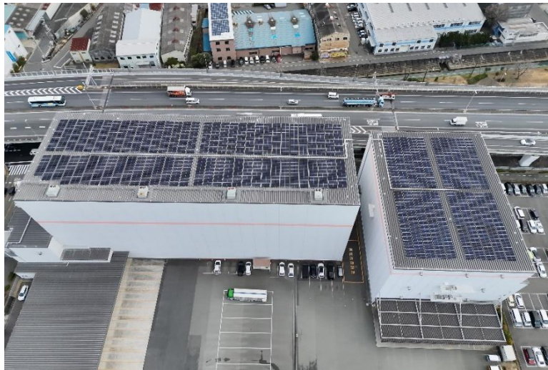
太陽光発電システムを設置した東洋メビウス 大阪支店
