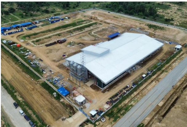
本工場の建設場所 全景
