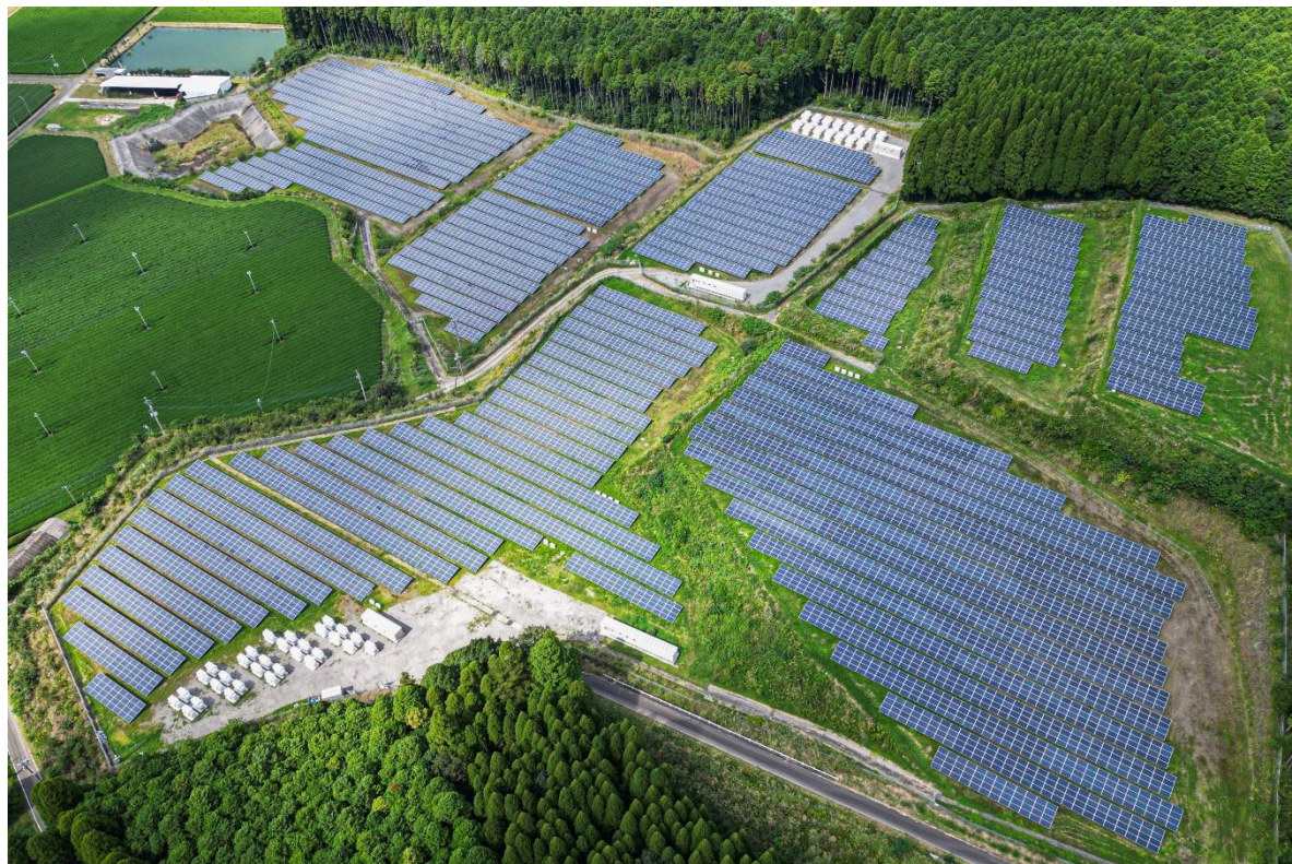
蓄電池を併設した太陽光発電所（所在地：鹿児島県始良郡湧水町）
