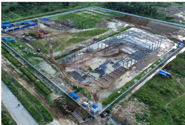
本工場の建設場所 全景
