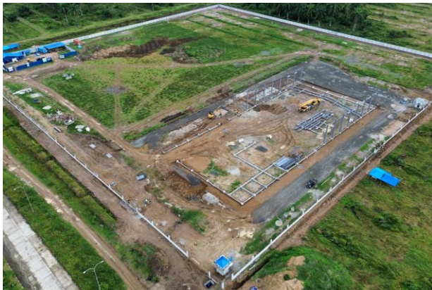
本工場の建設場所 全景
