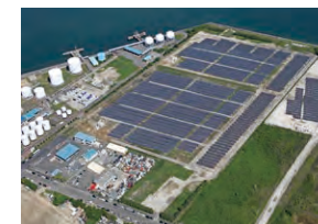
門司太陽光発電所
