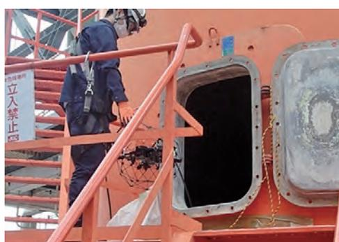
ドローンを用いた煙突内部点検
