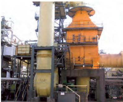
COボイラー排煙脱硝装置
