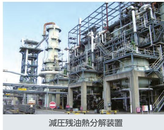
減圧残油熱分解装置
