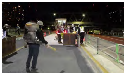
遮熱性舗装の施工
