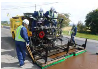
専用車両による敷き均し状況
