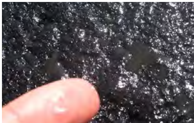
路面温度5℃で散布から1分後の状況
