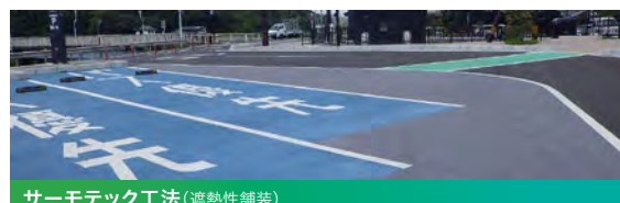
サーモテック工法 (遮熱性舗装)
