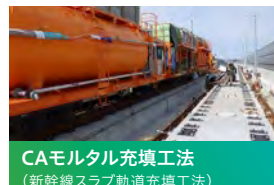
CAモルタル充填工法 (新幹線スラブ軌道充填工法)
