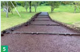
間伐材を燃やさずにリサイクルできる「アスウッド舗装」
