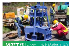
MR 2 工法 (マンホール上部補修工法)
