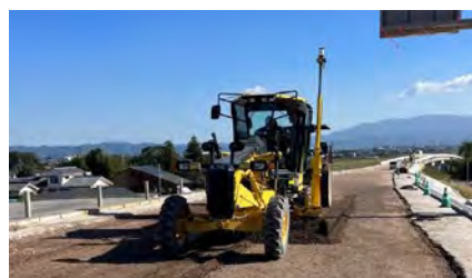
マシンコントロール仕様のモーターグレーダー
