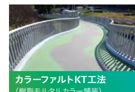
カラーファルトKT工法 (樹脂モルタルカラー舗装)
