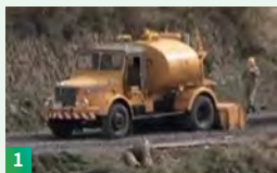
路上混合式工法で砂利道を舗装に変える「カチオゾール」
