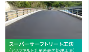
スーパーサフトリート工法 (アスファルト乳剤系表面処理工法)
