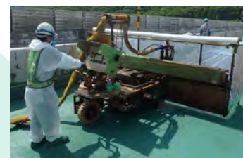
バイナダ散布ロボットを活用したHQ/ハイブレンAU工法
