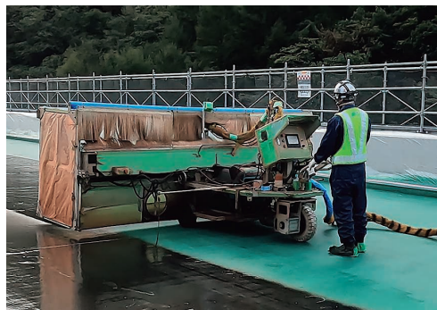
HQハイブレンAU工法（高性能床版防水工法）
