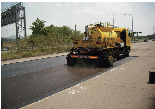
ディストリビュータによるアスファルト乳剤の散布
