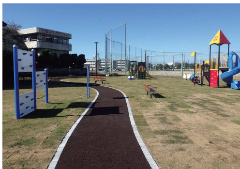
アスウッド工法（木材チップ舗装）
