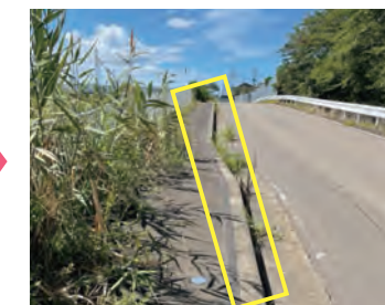
施工後1年以上経過
