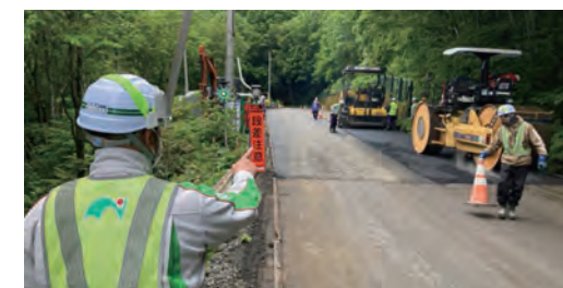
現場における作業状況の確認
