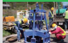
MR²工法 (マンホール上部補修工法)
