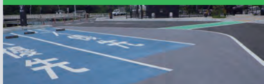
サーモテック工法 (遮熱性舗装)
