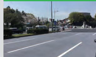
サーモテック工法 (遮熱性舗装)
