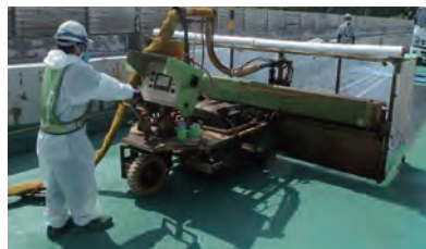
パインダ散布ロボットを活用したHQハイプレAU工法
