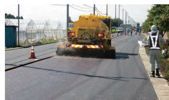
専用車両による散布状況
