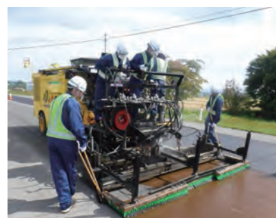
専用車両による敷き均し状況
