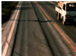
② モータリゼーションの進展により生じたわだち掘れの対策に「ポリファルトSS」
