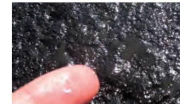
路面温度5℃で散布から1分後の状況
