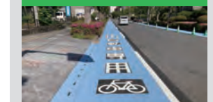
コールカットR工法 (樹脂系滑り止め舗装)
