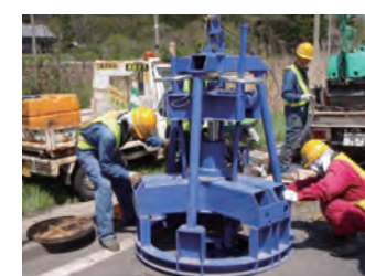
施工状況(マンホールフレームの撤去)
