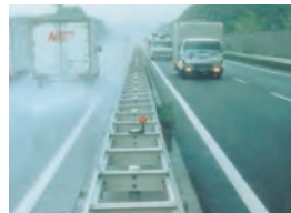
④ 雨天時の水はねを抑制し視認性を高め安全に寄与する「タフファルトスーパー」
