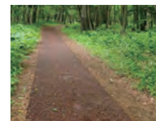
アスウッド舗装
