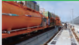
CAモルタル充填工法 (新幹線スラブ軌道充填工法)
