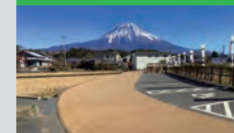
カラーファルトTO工法 (自然石舗装)
