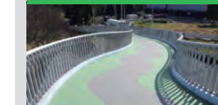
カラーファルトKT工法 (樹脂モルタルカラー舗装)
