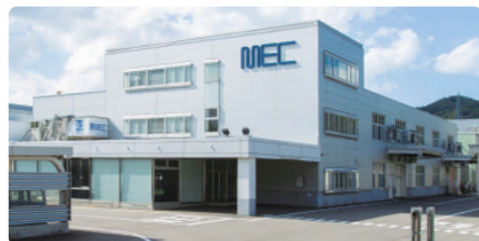
長岡工場外観
