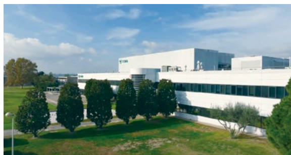
Towa INT マルトレージャス工場
