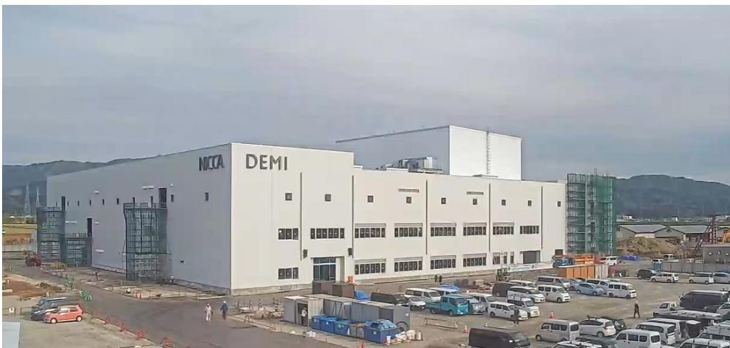
建設工事の様子(4月24日 時点)
